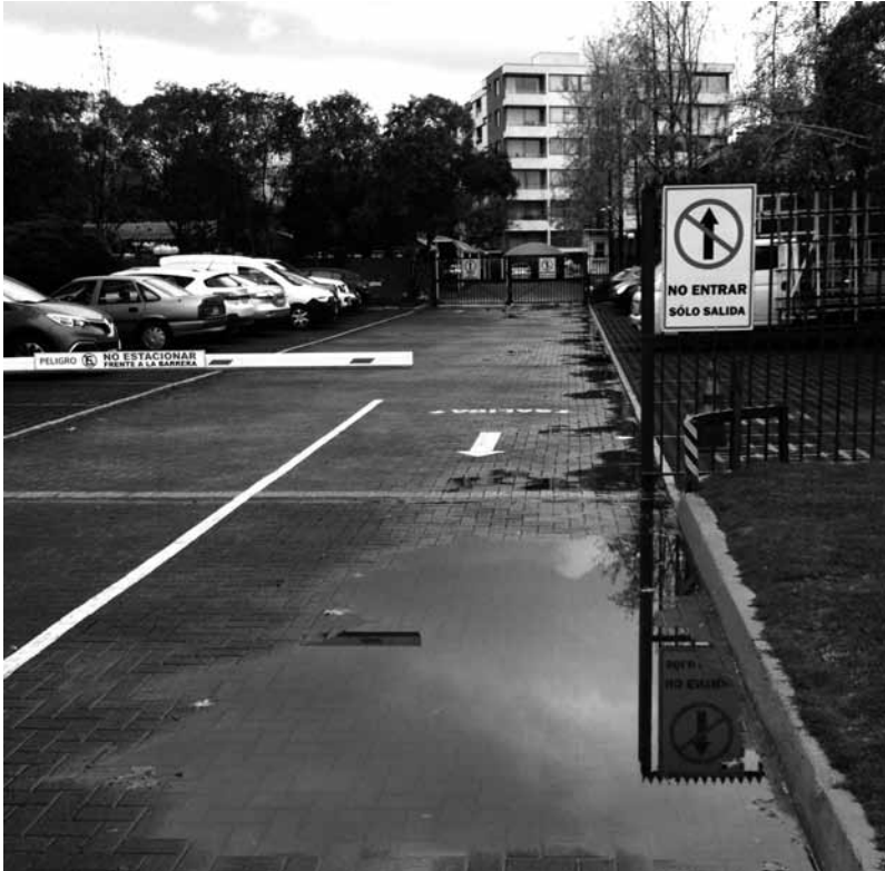
Figura 3. Poza de agua interviene continuidad y estructura de la calzada de acceso, vereda sur Av. Francisco Bilbao. 200 cm. ancho x 350 largo cm. Registro: 18 de junio 2018, 9:45 hrs. © Ángela Ramírez.
