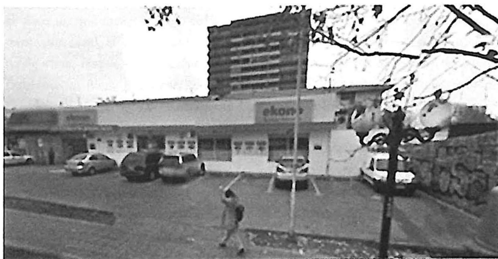
Registro web exterior supermercado (2014).
